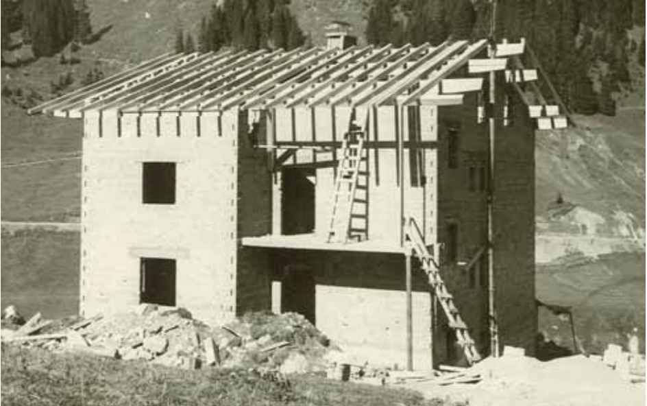
Abb. 10: Der fertige Rohbau (1959)
