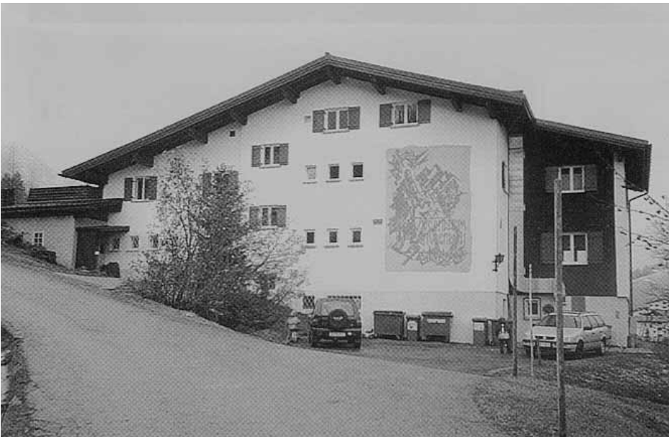
Abb. 20: Nordseite des Jugendheimes im Spätherbst 1997 (neue Fenster und Läden, Ablufikanal der Küchenlüftung)
